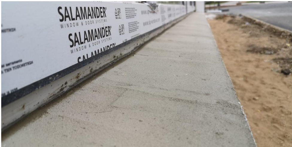
Pildil mastiksiga tehtud liide.
