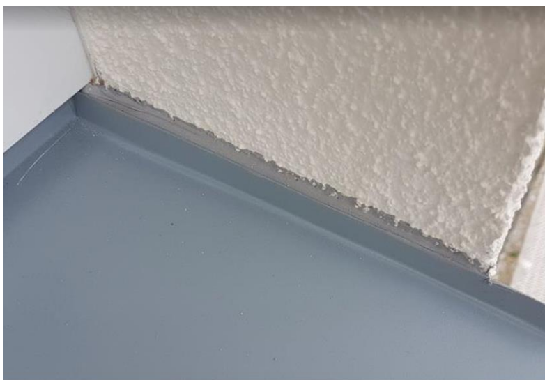
Pildil aknapleki paigaldus aknapõskede vahele. Pleki ja seina vahel isepaisuv tihend. Tihendi peale seina ja pleki vahele lastakse UV kindel mastiks.
