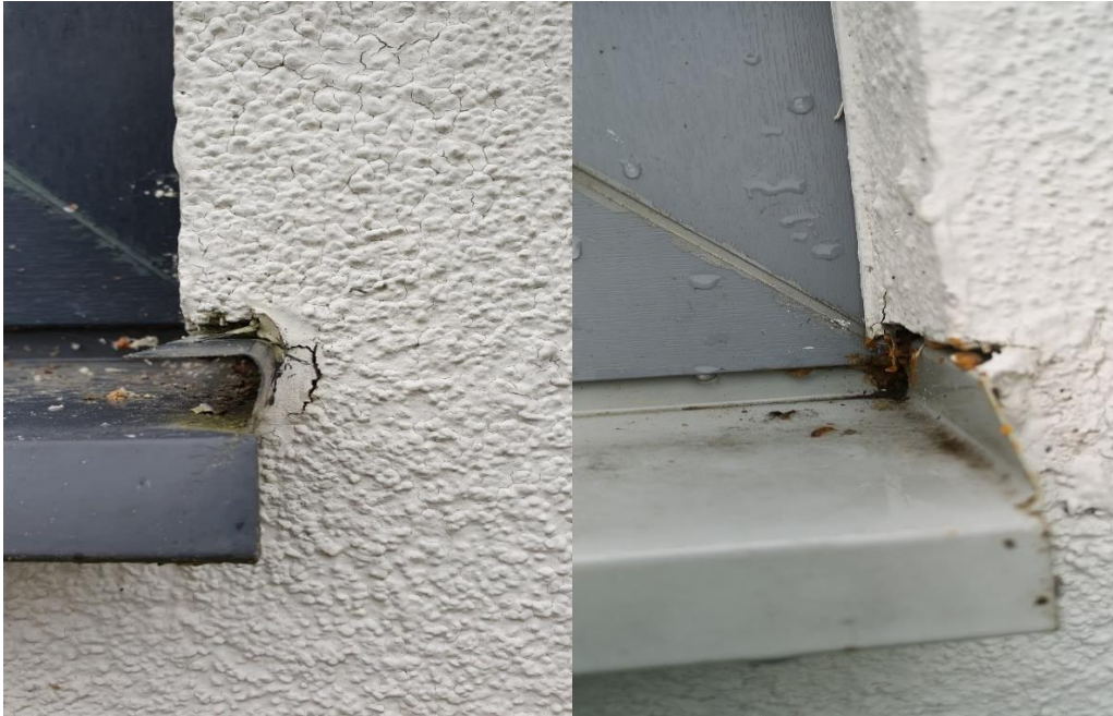
Piltidel näha valesti paigaldatud sisse löigatud plekid.
