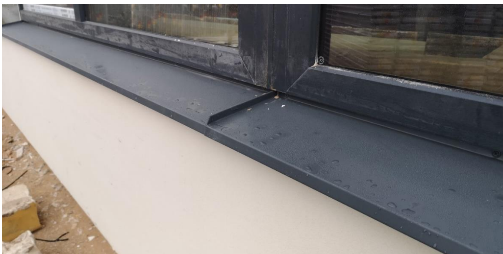
Pildil valtsitud plekk. Milline on õige lahendus plekkide liitmisel kõikidel plekkidel. Ka parapeti plekkidel.
