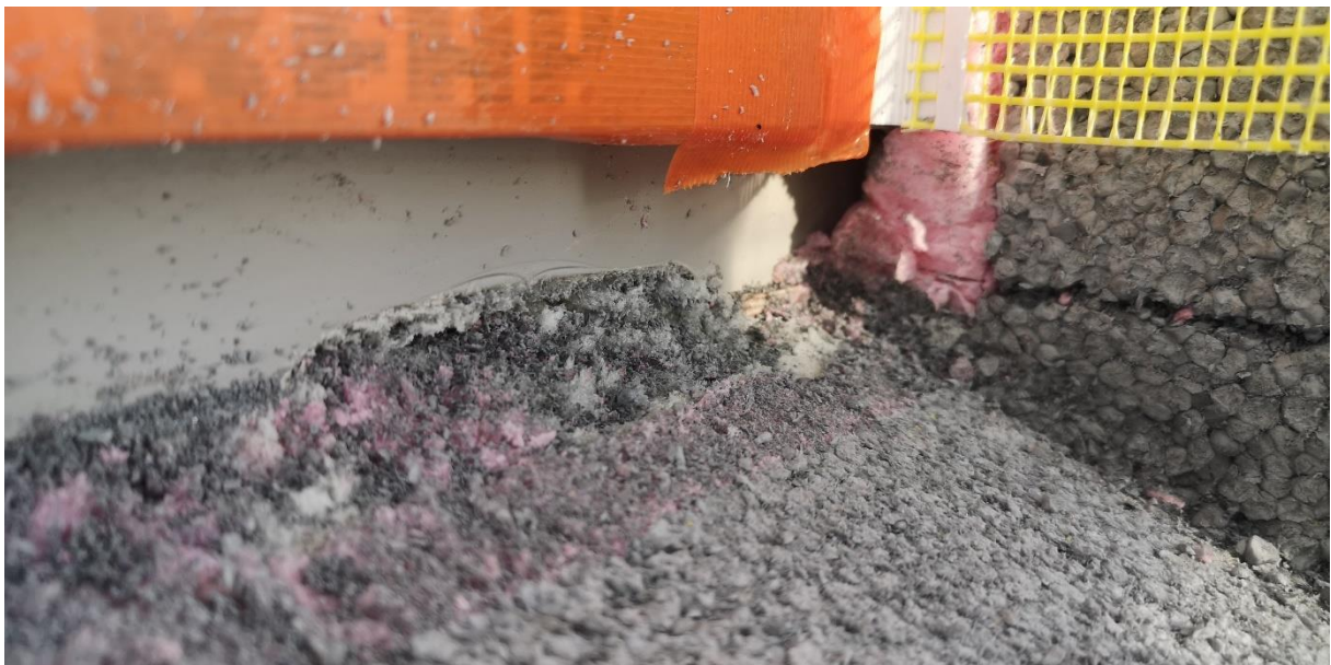
Pöörata tuleb tähelepanu akna alusnurkade tihendamisele. Vahuga ja pärast mastiksiga.
