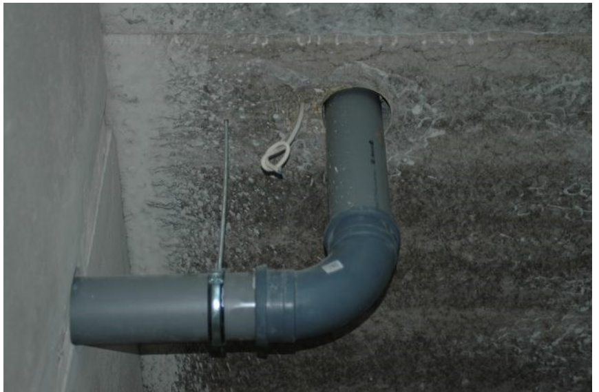
Sadevee torustikud peavad isoleeritud olema ka konstruktsiooni sees ehk avad peavad olema suuremad
