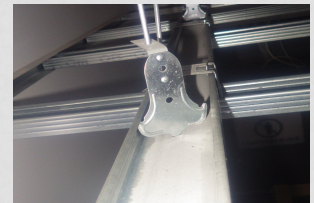
Traatankurriputi ei ole kinnitatud korrektselt CD profiili
