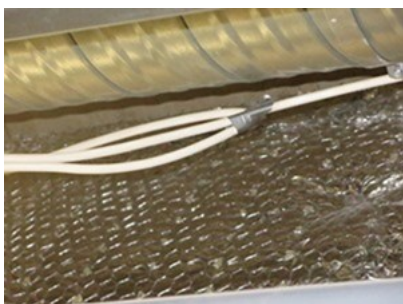
25. „Harutoos“? Kui teip „rikneb“ ja kaablisooned puutuvad isolatsiooni fooliumiga kokku, on kogu isolatsioon pinge all.
